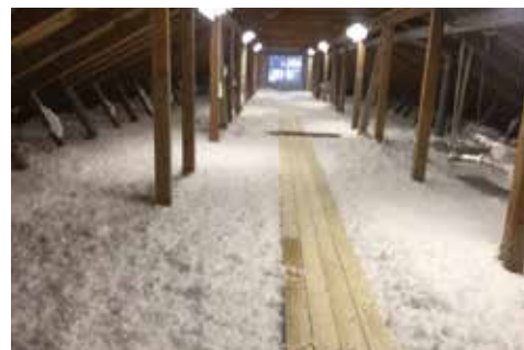
Etterisolering med 30 cm tykkelse på et kaldt loft på 100 kvm, utføres på under én time.
