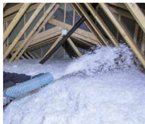
Blåseisolering er et effektivt alternativ til tradisjonell isolasjon og forenkler byggeprosessen.
