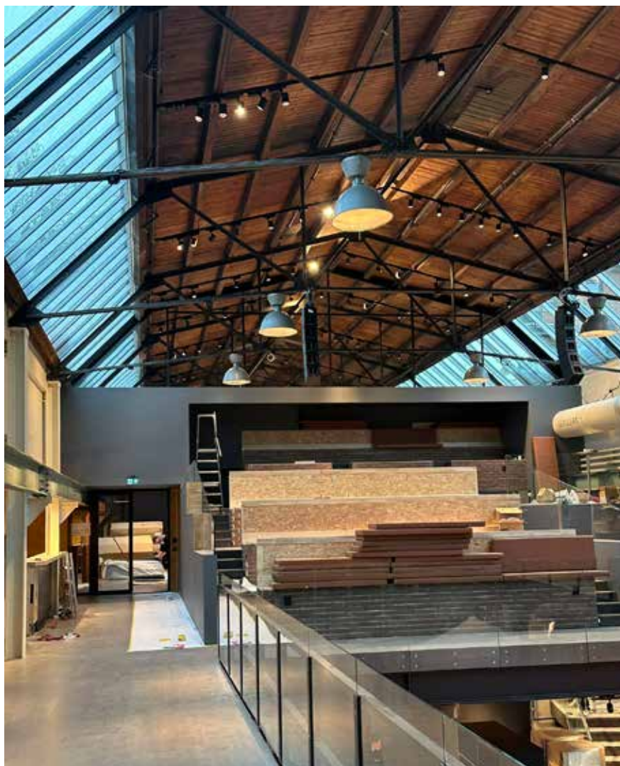
FOTO: OP BYGG
