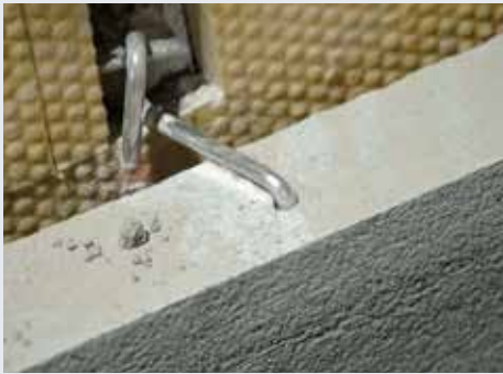
Steinen festes mekanisk i tillegg til vanlig bakstøp.
